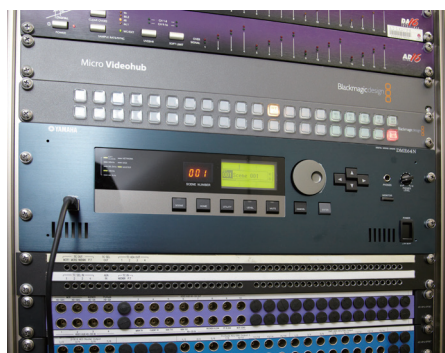
マシン・ルームに設置されたヤマハ「DME64N」。EQ処理以外に、外部機器との連携や、モニター、コミュニケーション機能追加といった、「Nuage」のシステム拡張の役割も果たしている
